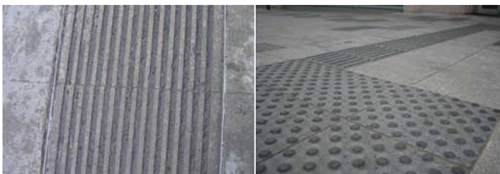
SLIKA 31 Neprimerna struktura s poglobljenimi kanali (levo) in ustrezna taktilna struktura, ki je glede na okoliški tlak izbočena (desno).
