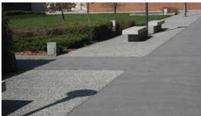
SLIKA 45 Razlike v tlakovanju kot pomoč pri orientaciji
